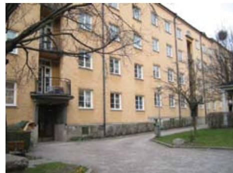
• En bonuseffekt blev att klagomålen från hyresgästerna minskade tack vare bättre värmekomfort. Dessutom visar utvärderingen att koldioxidutsläppen minskade med 23 ton.
