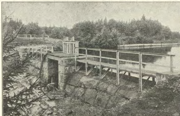
Fig. 14. Spärrdammen över Hooån vid Tjärnäs. Foto. E. ERIKSSON.
