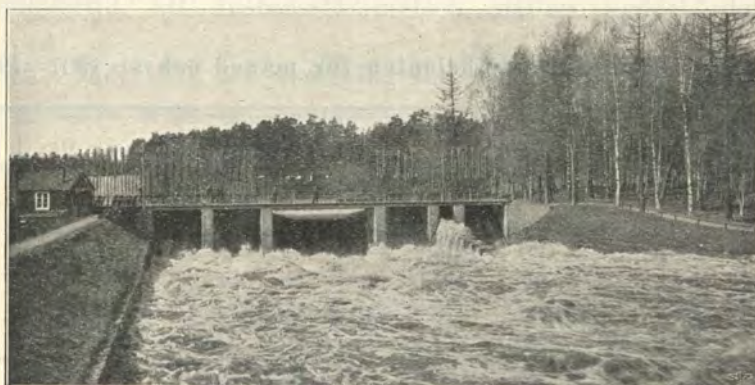
Fig. 9. Dambyggnaden vid Strömdalen vid högvatten. Foto. G. REIMERS. Avloppet till kraftverket till v. å bilden.
