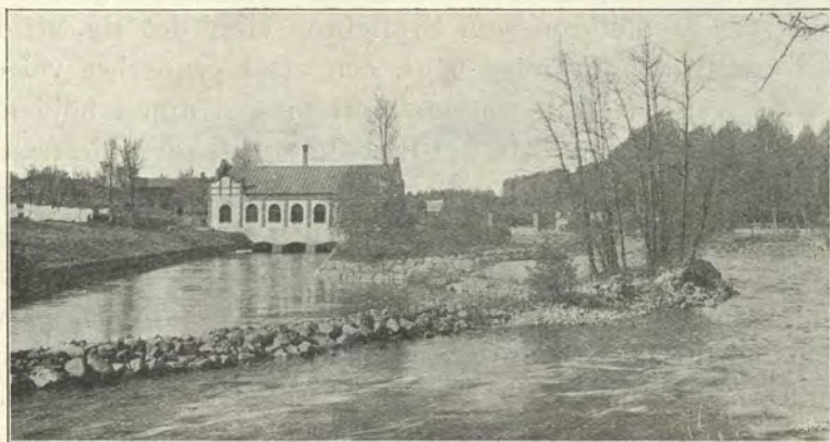
Fig. 8. Strömdalens kraftstation vid Gävle.
