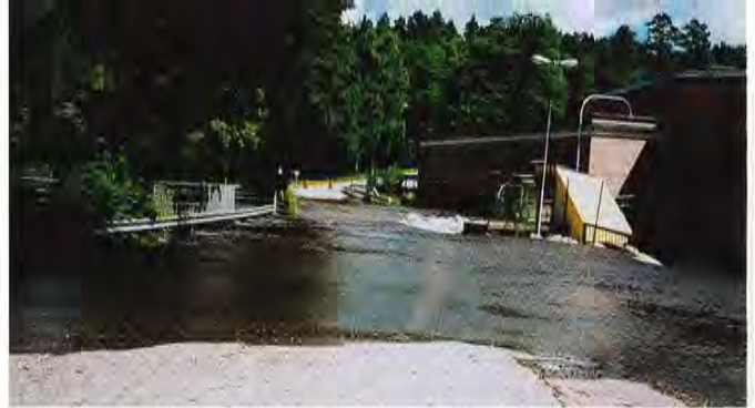
Översvämning av väg och damm vid Silverdalens pappersbruk den 9 juli 2003
