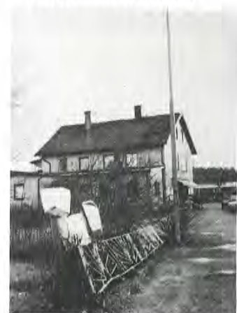
Utmed gatan i Moheda, där tromben drog fram, böjdes ett lågt järnräcke åt norr i hela sin längd, ca 30 m
