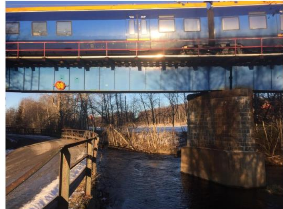
Figur 4. Järnvägsbron över Gådeån (nr 13 i tabell 1) där en av de murade bropelarna står mitt i ån.
