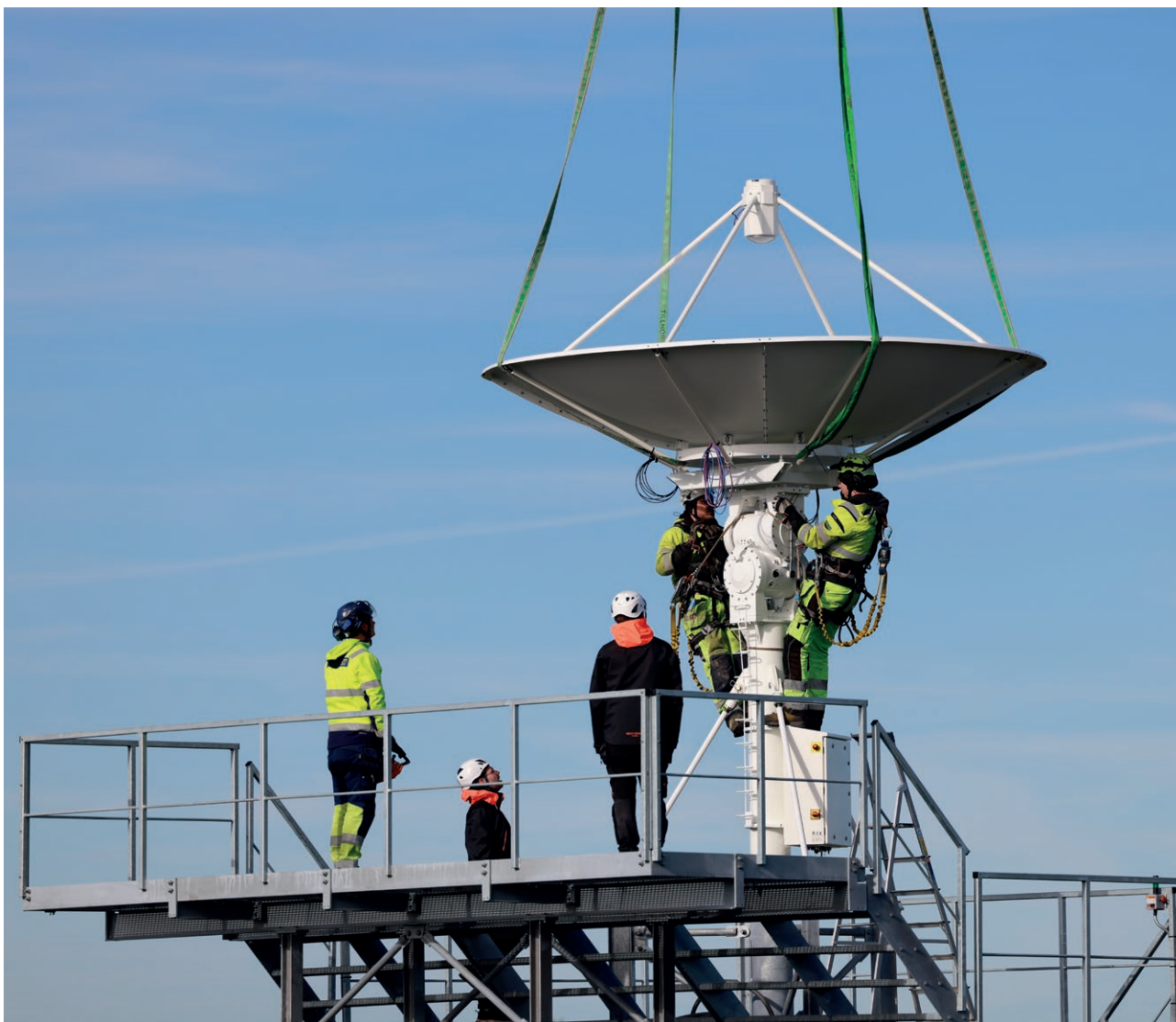
Montering av en ny antenn för mottagning av satellitdata installeras i ett nybyggt torn på SMHI:s område i Norrköping. Foto: SMHI
