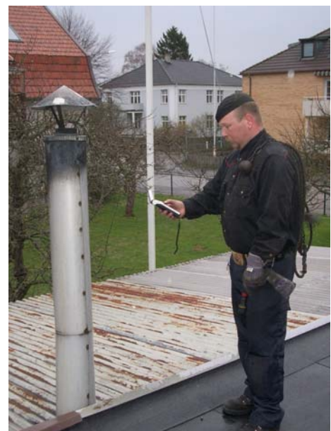
Med en GPS i handen på skorstensfejaren kunde exakta GIS-koder för utsläppskällan bestämmas.
