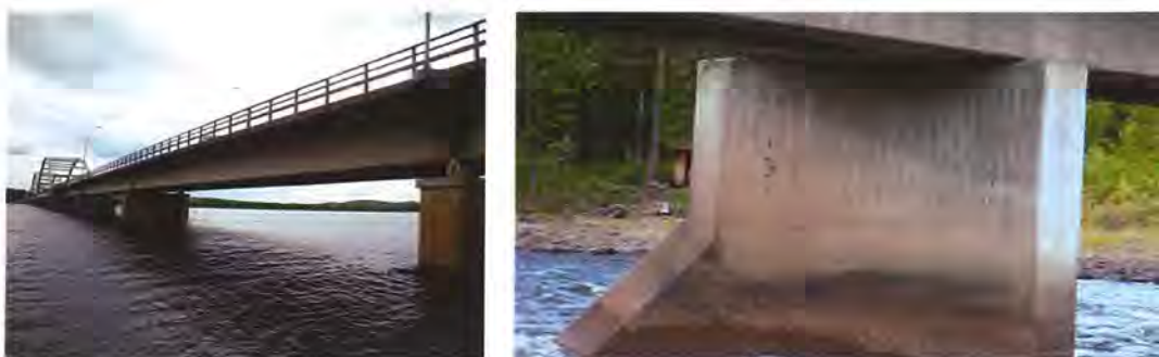
Figur 12. Broar beskrivs i den hydrauliska modellen. Till vänster syns bron vid Övertorneå. Till höger visas ett exempel på att iakttagelser vid rekognosering kan ge information om vattennivåer.
