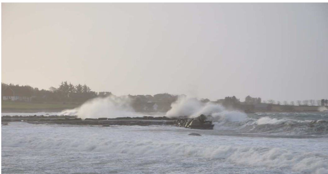
Figur 22. Exempel på hur vågor spolar över konstruktioner, i detta fall en vågbrytare avsedd för att skydda jordbruksmarken mot havets krafter. Foto: Signild Nerheim
