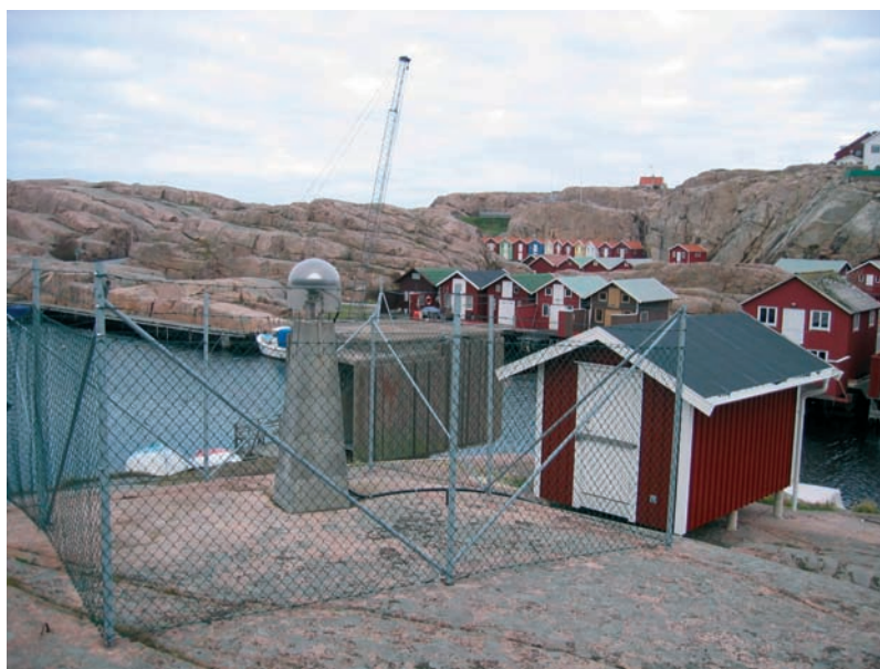
Figur 4. Mareografen i Smögen (betongbyggnaden i bakgrunden), Lantmäteriets GPS-station (pelaren i förgrunden) och en station för mätning av absolut tyngdkraft (den röda byggnaden till höger). Från GPS-stationen kan den absoluta landhöjningen bestämmas, vilken är viktig vid beräkningar av den globala havsnivåhöjningen.
