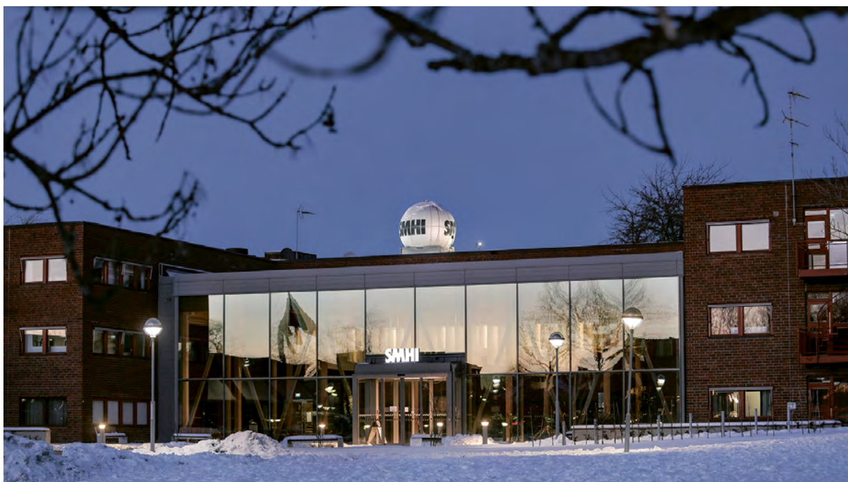
SMHIs lokaler i Norrköping har byggts om och fått en ny entré. I samband med renoveringen har lokalerna anpassats till verksamheten och bland annat gett nya möjligheter till moderna mötesrum.
