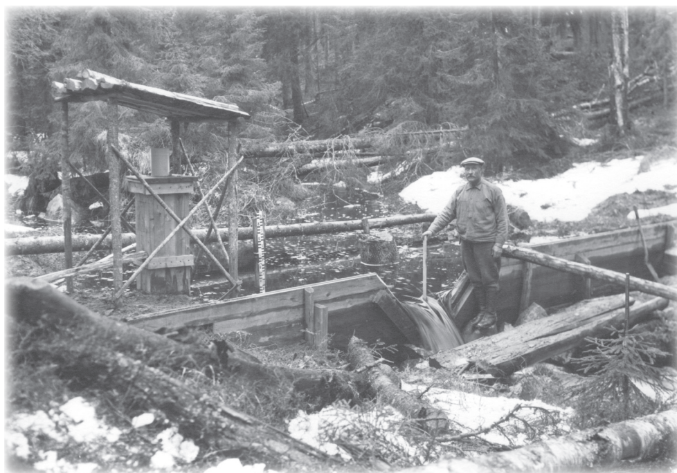
V-format överfall för mätning av vattenstånd/vattenföring. Himmelsbergets registrerande pegel 1926.
